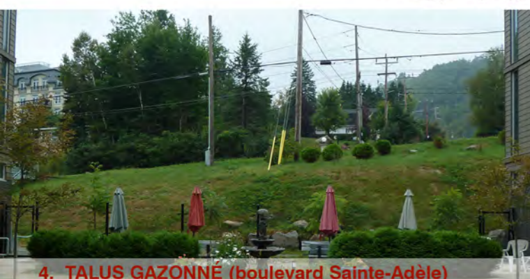
4. TALUS GAZONNÉ (boulevard Sainte-Adèle)
